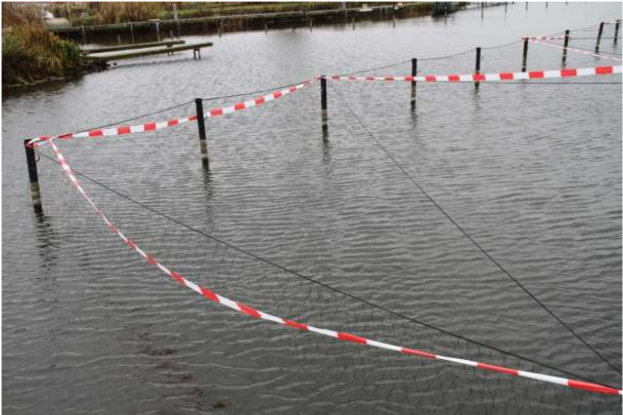
Foto 2: Fertige Netzabspannung im Hafenbecken der Seglervereinigung Húde.
