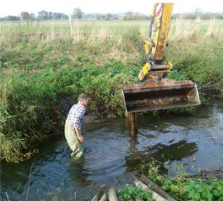
li: Frank Behrens, Timo & Andreas Hellmann und Willi Bellersen an der Sachsenhägener Aue. oben: Ein Bagger setzt Wasserbaupfähle. Mitglieder des ASV verflochten sie mit Weidenruten.
