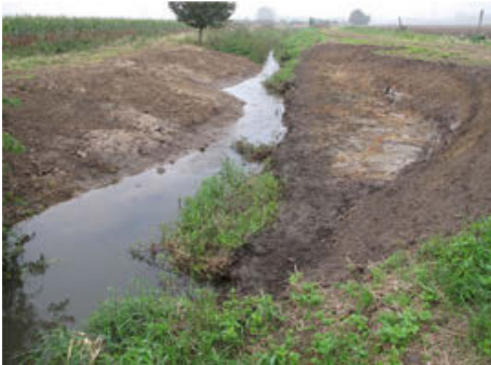
oben: Bagger legten auch Retentionsflächen an, die bei Hochwasserereignissen Wasser in neutrale Bereiche abführen. Fotos: ASV Sachsenhagen
