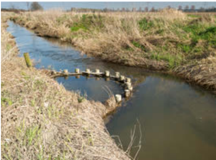
unten: Verschiedene Renaturierungsmaßnahmen im Verlauf der Aue, fotografiert im Frühjahr 2017. Sie fördern die Strömungsvarianz, legen natürliches Sohlsubstrat frei und schaffen Lebens- und Rückzugsräume für Jungfische und Fischnährtiere. Fotos: F. Möllers / AVN
