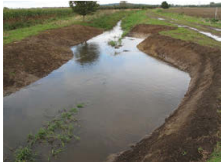
oben: Bagger legten auch Retentionsflächen an, die bei Hochwasserereignissen Wasser in neutrale Bereiche abführen. Fotos: ASV Sachsenhagen
