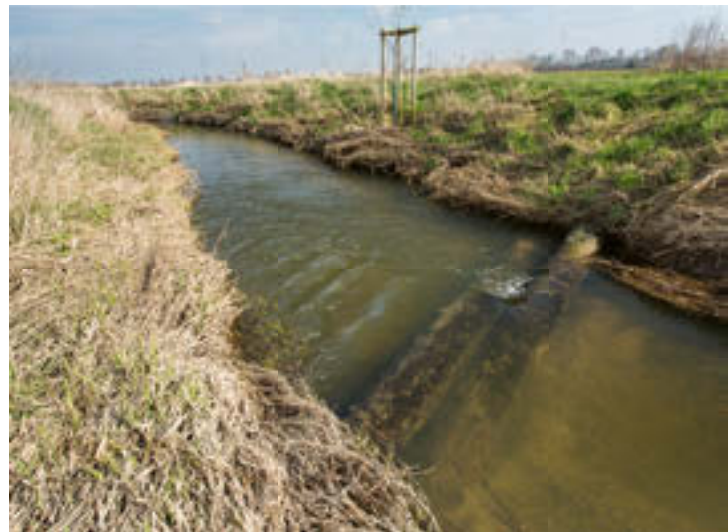
unten: Verschiedene Renaturierungsmaßnahmen im Verlauf der Aue, fotografiert im Frühjahr 2017. Sie fördern die Strömungsvarianz, legen natürliches Sohlsubstrat frei und schaffen Lebens- und Rückzugsräume für Jungfische und Fischnährtiere. Fotos: F. Möllers / AVN
