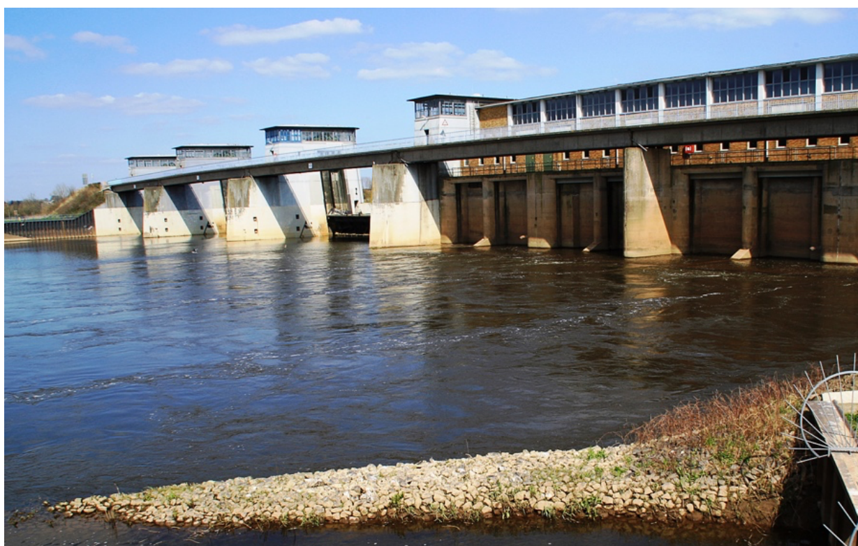
Abb. 7: Wasserkraftanlage an der Weser, © Foto: R. Gerken
