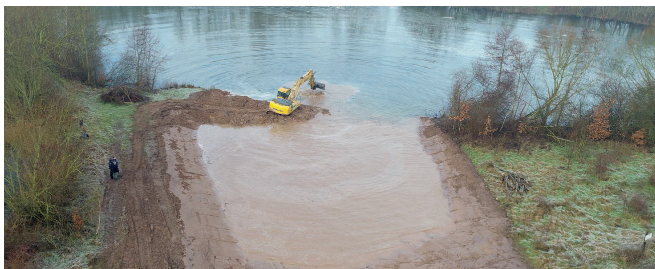
Bau einer Flachwasserzone
