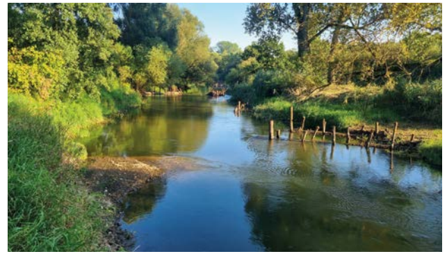
Strömunglenker aus Kies (vorne links) und durch Pfosten gehaltene Baumstämme in der Oker sorgen für mehr Strömungs- und Strukturvielfalt. © Aktion Fischotterschutz
