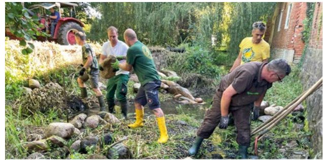
Mit vollem Körpereinsatz haben Mitglieder der Natur- und Angelvereinigung Aller-Ohre-Drömling die Fischtreppe in Brome optimiert. © Katrin Wolf (AVN)
