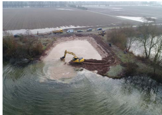
Ein Bagger gräbt eine Flachwasserzone in einem Versuchssee bei Nienburg. © Thomas Klefoth
